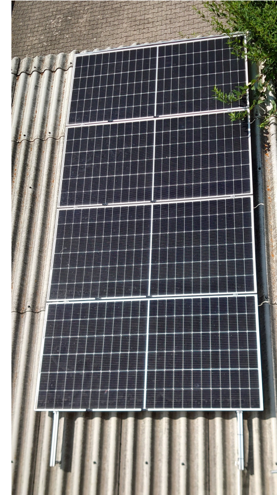
Günstige und schnelle DIY-Montage mittels Stockschrauben
